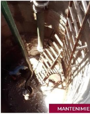
MANTENIMIENTO A CARCAMO REBOMBEO LAGUNA DE OXIDACIÓN
